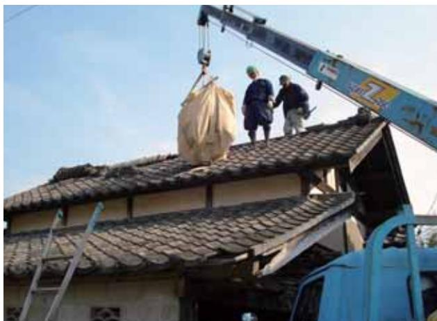
震災の影響により割れた瓦の撤去作業
