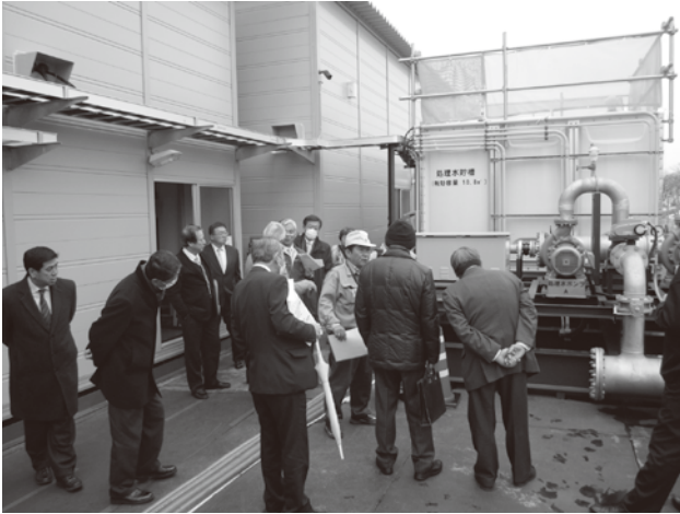
浄化施設内部への視察も行った
