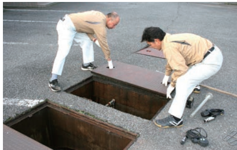
浄化槽内点検中(マンホールを開けているところ(左) 溶存酸素(DO)のチェック(右))
