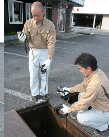
浄化槽内点検中(マンホールを開けているところ(左) 溶存酸素(DO)のチェック(右))
