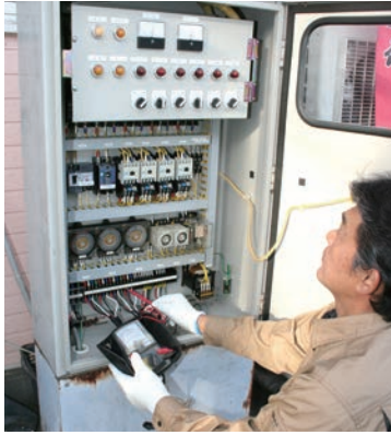
汚水処理制御盤のチェック
