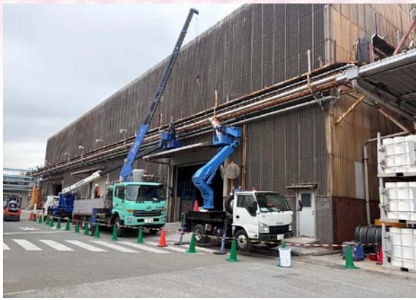
配管取付 — 配管工事
