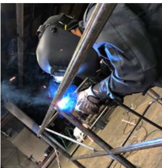
工場での手摺溶接
