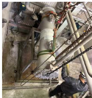
機械設備の据付
